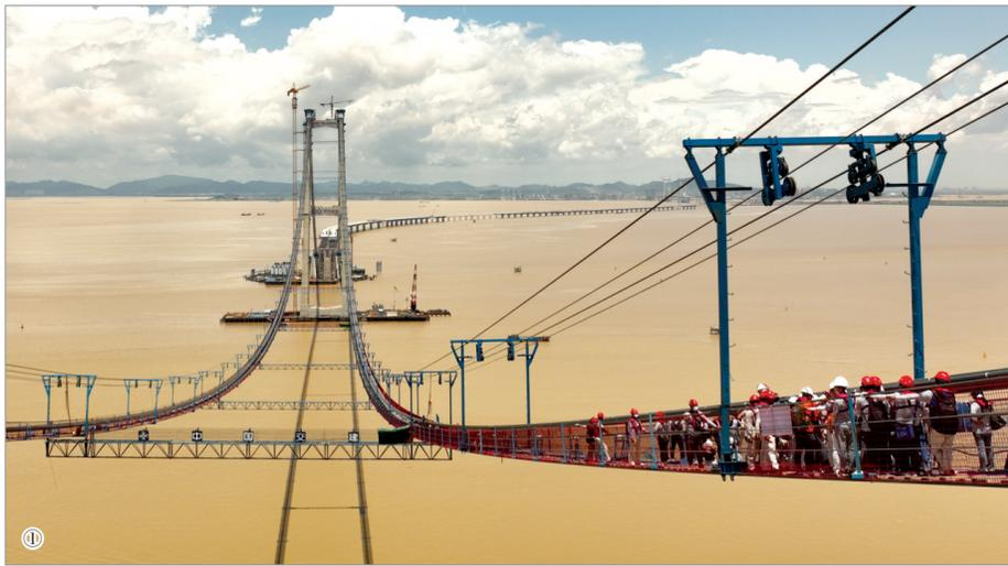
丝总量超过5万根,加起来长度可绕地球近4圈。大桥建成后,两根主缆最大张力将达到10万吨以上,可以拉起2万头成年大象。
